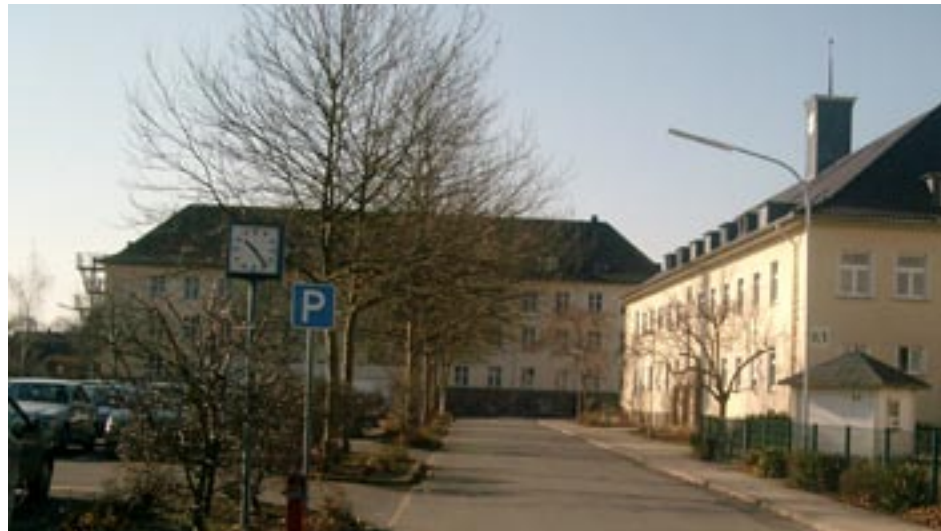
Gebäude im Norden bzw. Südwesten des Plangebietes
